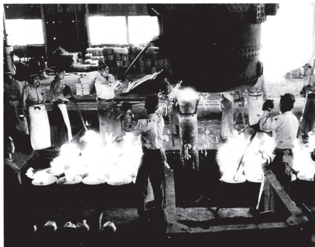
図6 250kg鋼塊下注風景（浮板使用）
